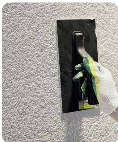
Приглаживаем покрытие пластиковой кельмой, круговыми движениями в одном направлении
