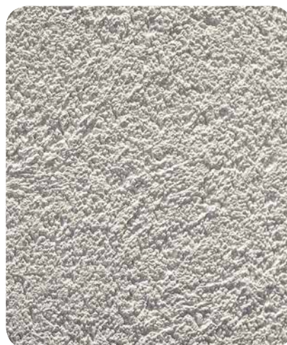
Готовое «камешковое» покрытие
